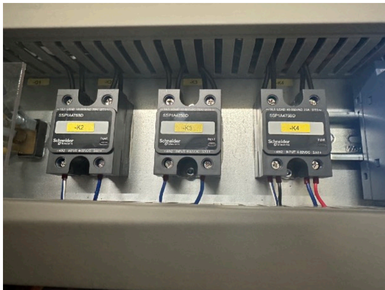
Abbildung Anschluss an das Solid State Relais K4
