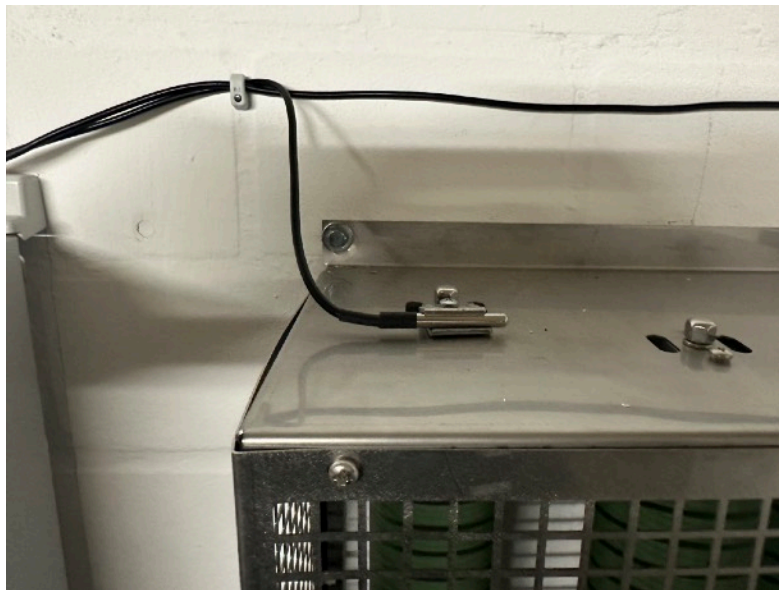
Abbildung Beispiel Installation Temperatursensor
